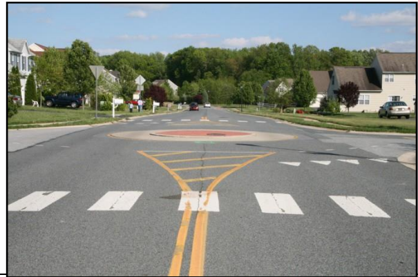
MINI ROUNDABOUT (Rose Hill Drive)
